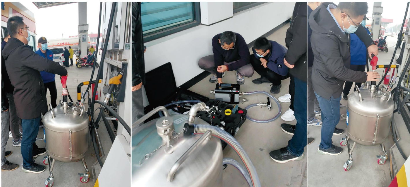
上海某加油站油气泄露检测
